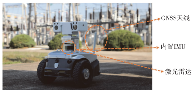
图4 变电站环境以及数据采集载体
